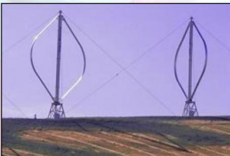
Os sistemas de eixo vertical tem a vantagem de captarem vento em qualquer direcção.
