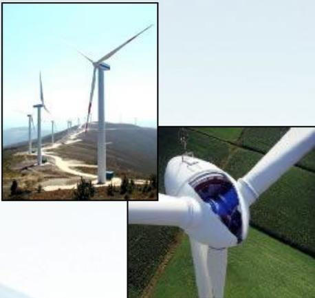
Os sistemas de eixo horizontal consistem numa estrutura sólida elevada, tipo torre, com duas ou três pás aerodinâmicas que podem ser orientadas de acordo com a direcção do vento.
